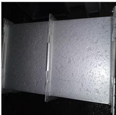
③接続後、一昼夜風雨にさらし、テストします。
