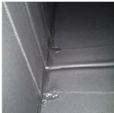
②組み立て後、断熱施工を施します。
